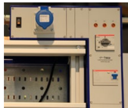
Ausführung Energiekanal aufgesetzt
